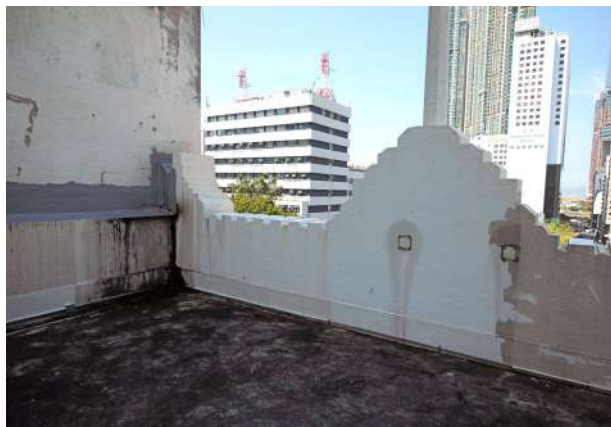
(彌敦道190號屋頂，攝於2021年9月)
